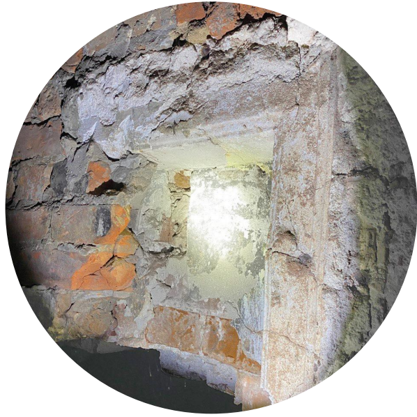
фрагмент наличника оконного проема (не позднее 18 века)
