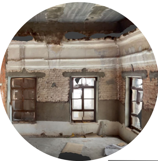
Сохранившиеся потолочно-пристенные тяги (19 век, арх.Шмидт А.К.)
