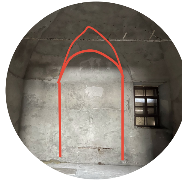
распалубка проема (не позднее 18 века)
